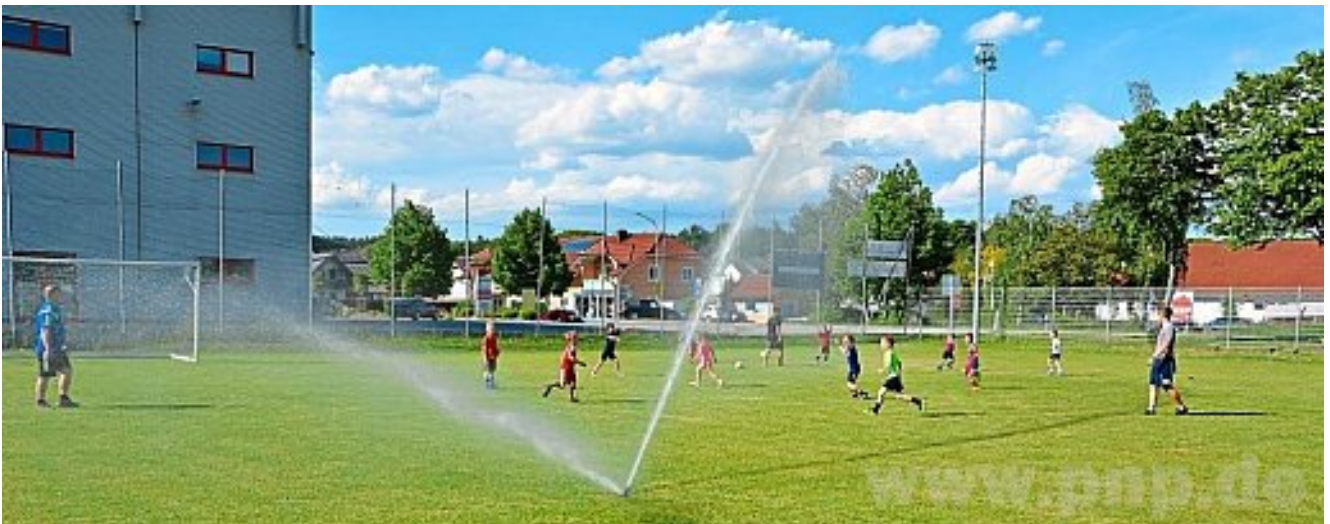
Auch das kann eine Beregnungsanlage: Kindern zwischendurch Spaß bereiten. Vornehmlich dient sie jedoch der Rasenpflege des Sportplatzes
