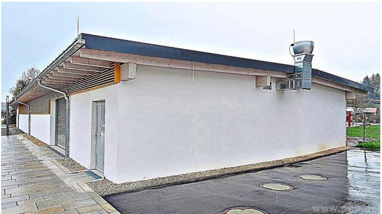
Mehrausgaben bei der Sanierung des Sanitär- und Kassengebäudes
